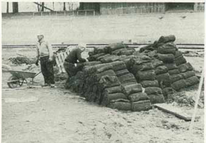
Darst. 4: Lagerung der Soden auf der Baustelle
